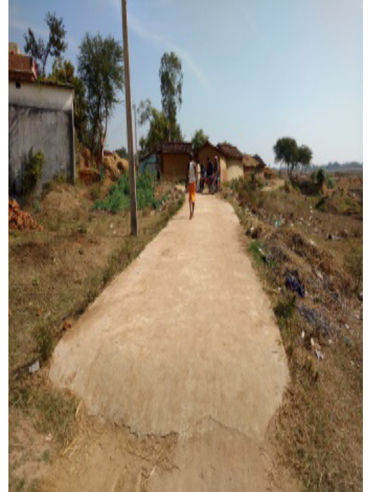
ग्राम पंचायत गहुआ में सड़क निर्माण
